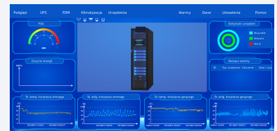
Zdalny monitoring stanu systemu
